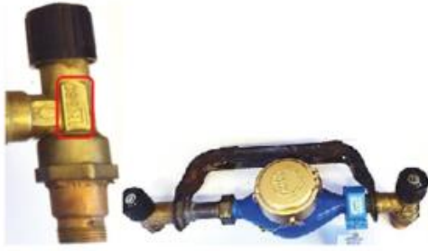
Bild på icke godkända avstängningsventiler.
